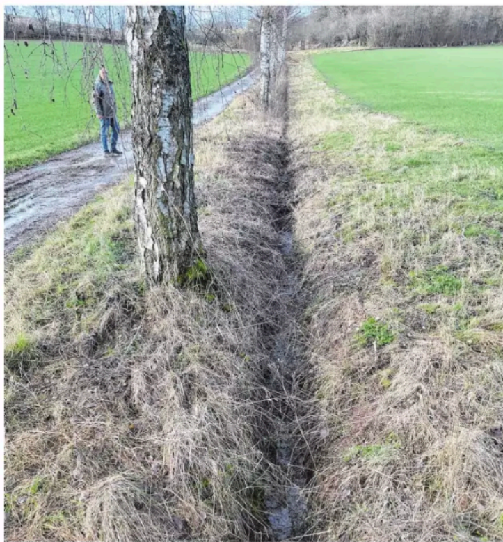
Entwässerungsgräben tragen dazu bei, dass es nicht so leicht zu Überschwemmungen kommt.
