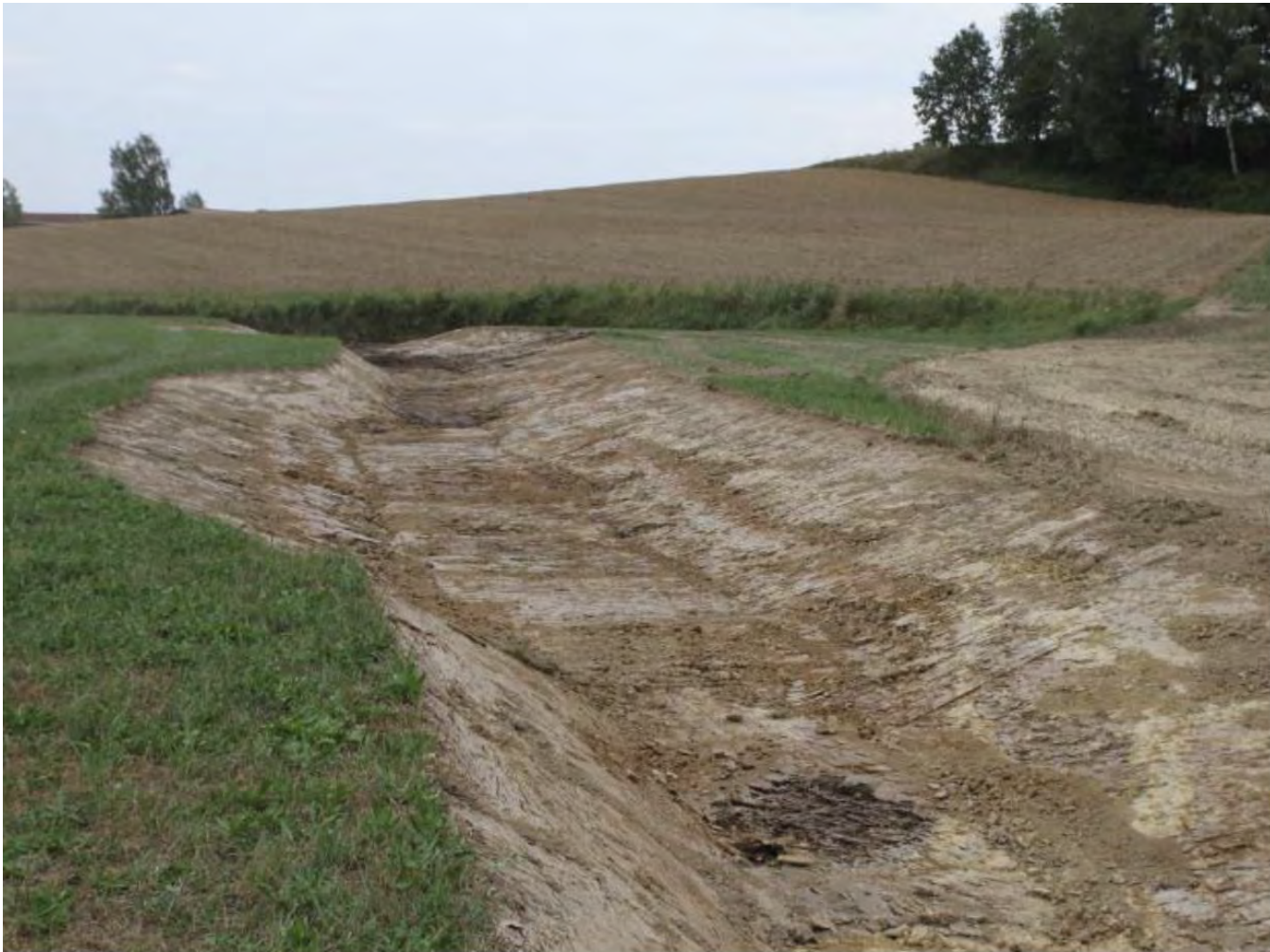
KULAP-B59 Maßnahme: Abfußmulde kurz nach dem Bau © Verwaltung für ländliche Entwicklung
