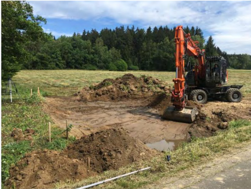
Bagger bei der Arbeit © Daniel Maurer, 10.07.2020, Weißenstadt
