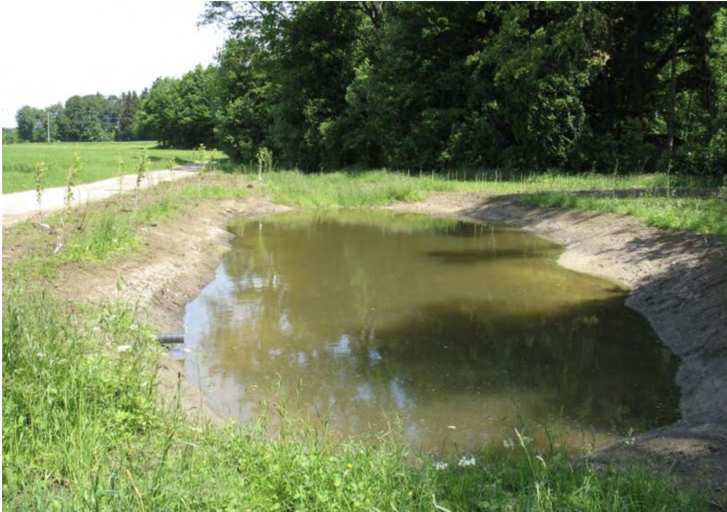
Ein Becken der Sickerstrecke nach Baufertigstellung © Verwaltung für ländliche Entwicklung
