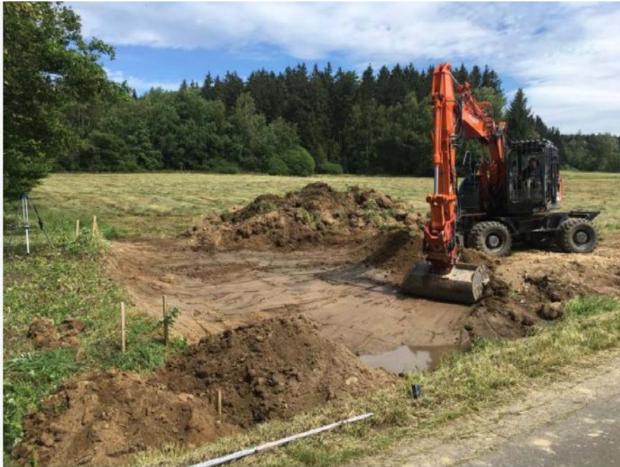
Bagger bei der Arbeit © Daniel Maurer, 10.07.2020, Weißenstadt
