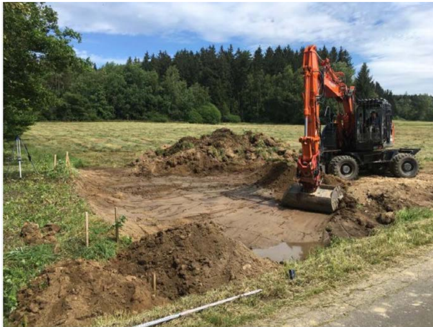
Bagger bei der Arbeit © Daniel Maurer, 10.07.2020, Weißenstadt
